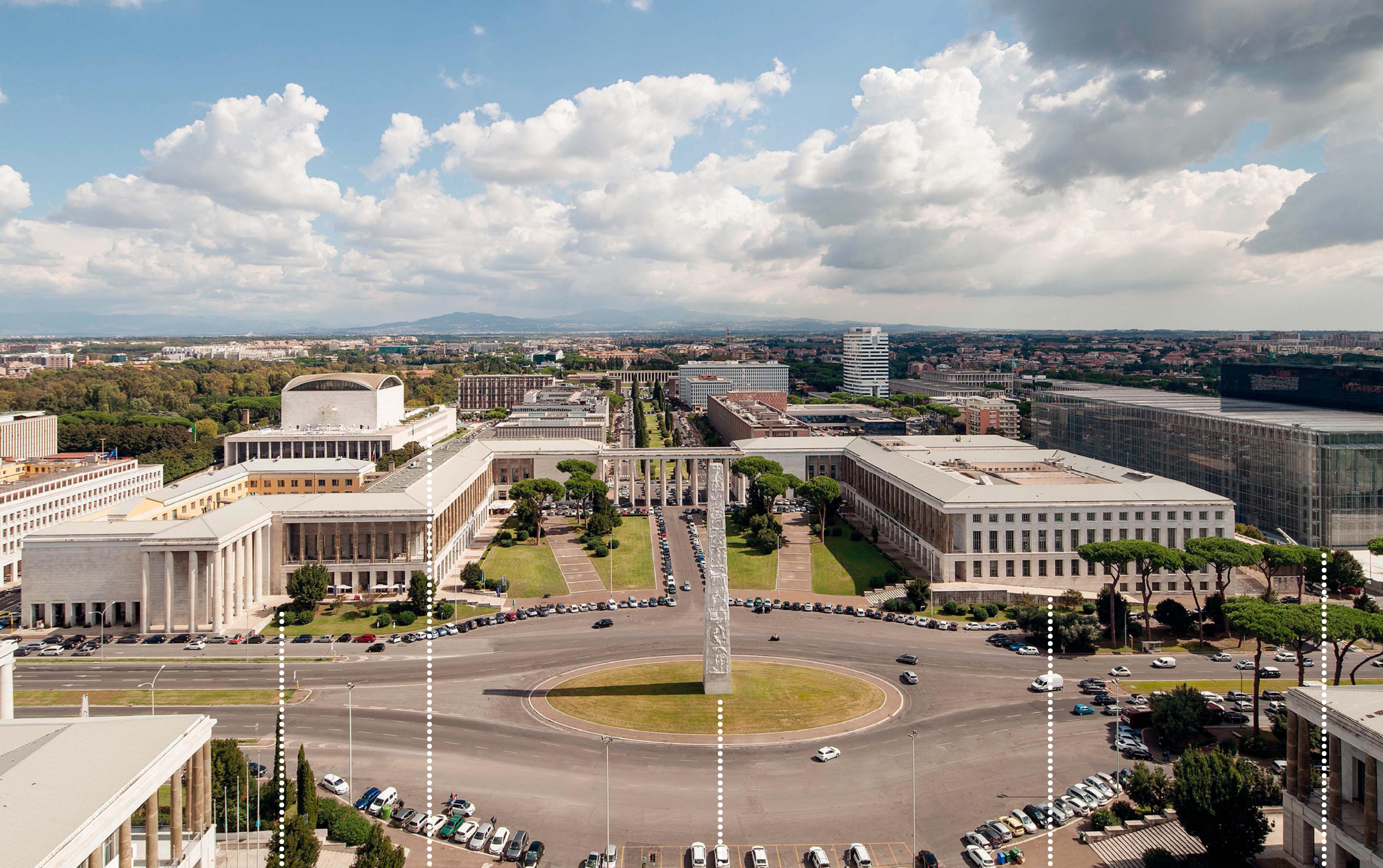
Palazzo Italia, la vista dal 18° piano. Palazzo Italia, view from the 18 th floor.
